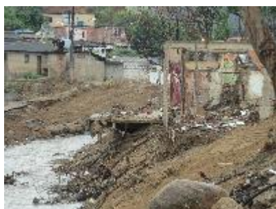
Fig 4 – Degradação ambiental, proveniente das chuvas.
